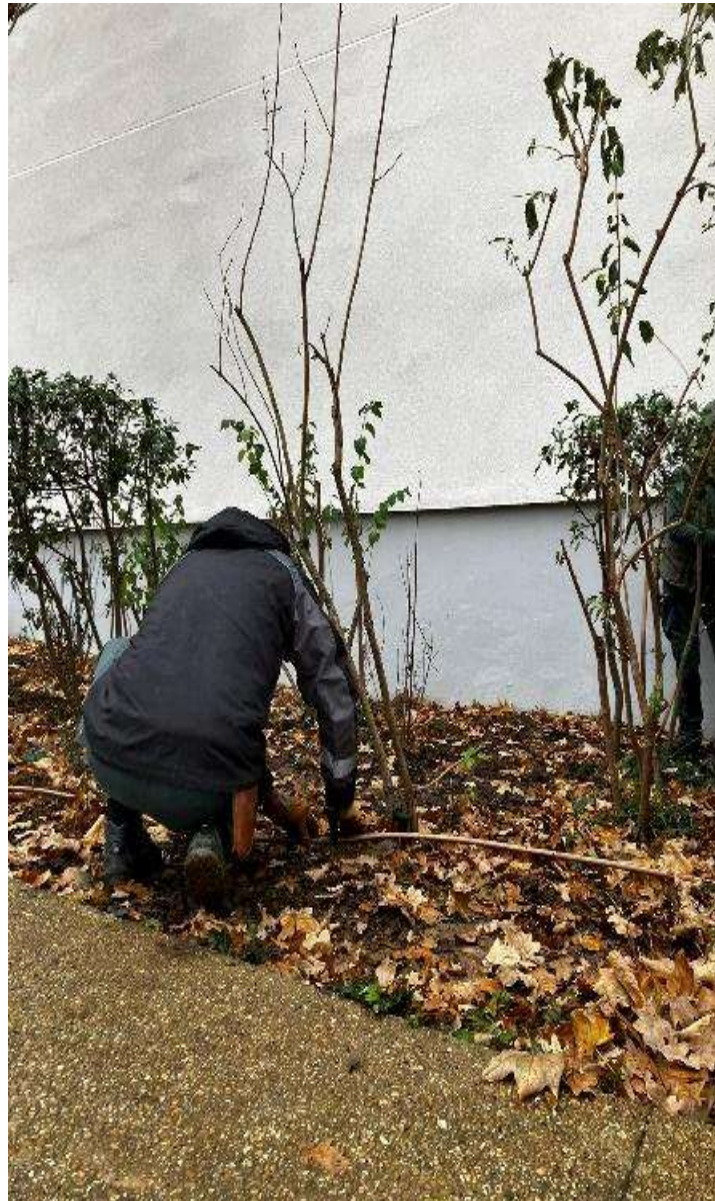
Figure 22 : Installation d'un système d'arrosage goutte-à-goutte. Source : Ana-Cristina Torres.
